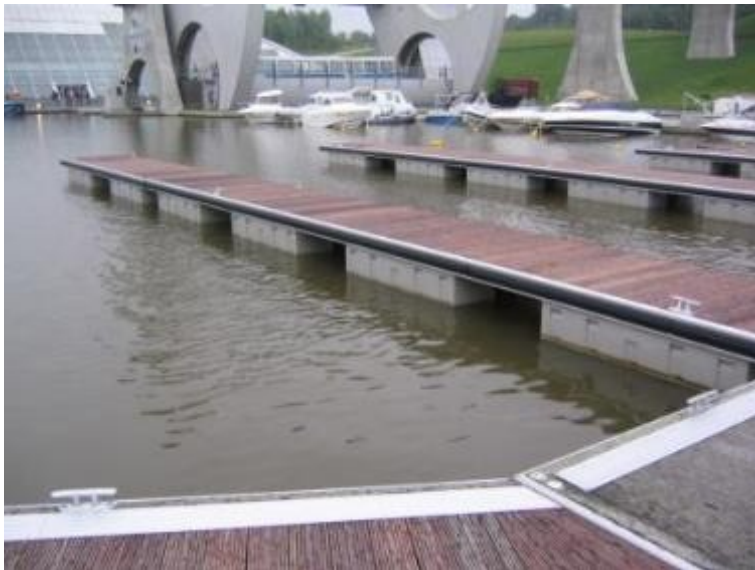
Фигура 30: Пример за плаваща понтонна система
